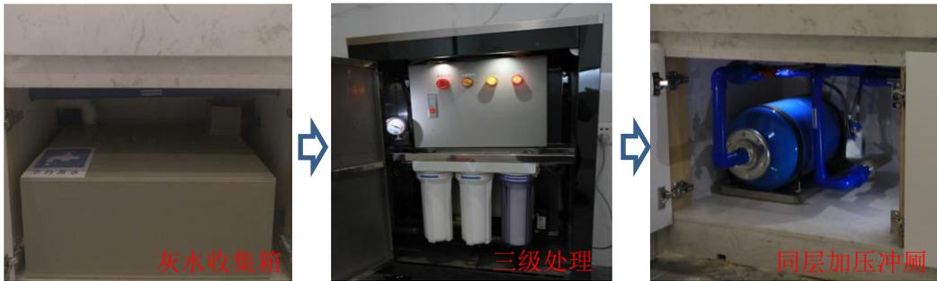
灰水利用：将洗手盆灰水收集，同层冲厕，节水率 30%
