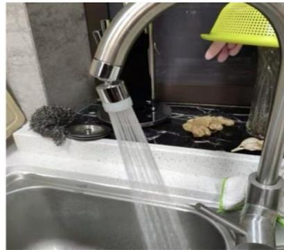
节水型水龙头：在龙头出水口处安装节水限流器，通过限流和涡流增压装置，在增加舒适感、保证洁净度的同时，高效节水 35%。
